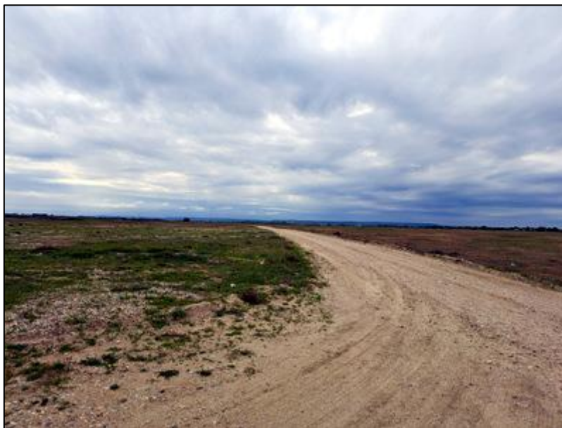
Figura nr. 11 – Aspect privind drum de exploatare situat pe teritoriul administrativ al comunei Giuvărăști, vizat pentru transportul agregatelor minerale extrase în urma activității de decolmatare a râului Olt
