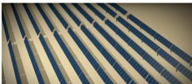
Figura 4. Exemplu de sistem de urmărire solară cu o singură axă
