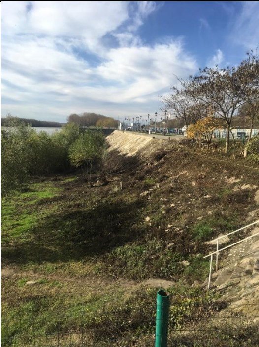
Zona lucrarilor cheu+platforma
