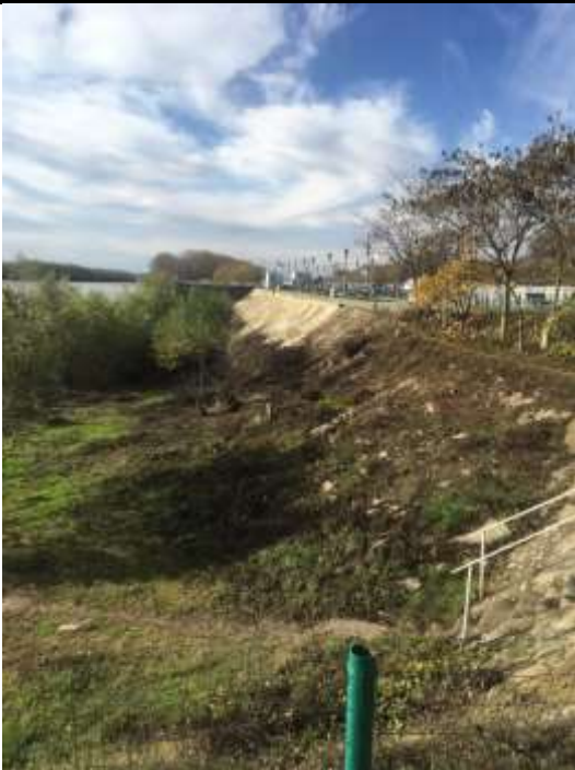
Zona lucrarilor cheu+platforma
