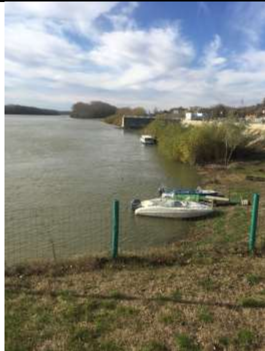
Zona lucrarilor cheu+platforma
