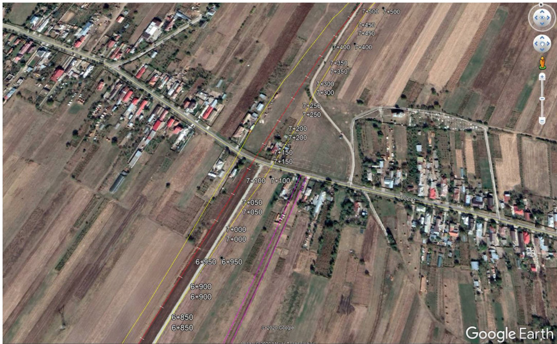
Figura 11. Zona in care traseul drumului expres Craiova - Pitesti este in vecinătatea locuințelor în extravilanul localității Pieșești
