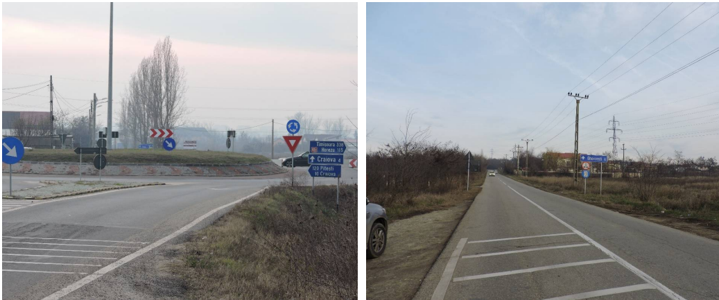
Figura 61. Vedere generală în zona km 0+000 al drumului expres Craiova – Pitești
