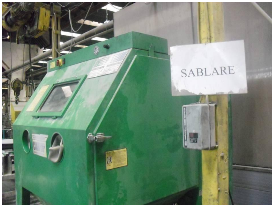
Fig.18. - Instalație de sablare cu alice din sticlă
