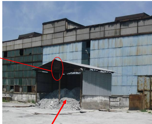
Depozit pentru zgură în exteriorul halelor, pe o suprafață betonată
